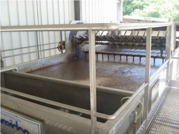
Figure 3.7 - clarificateur ou cellule de flottation
