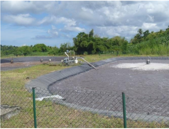
Figure 3.6 - Lagune tampon (droite), lagune aérobie (gauche)
