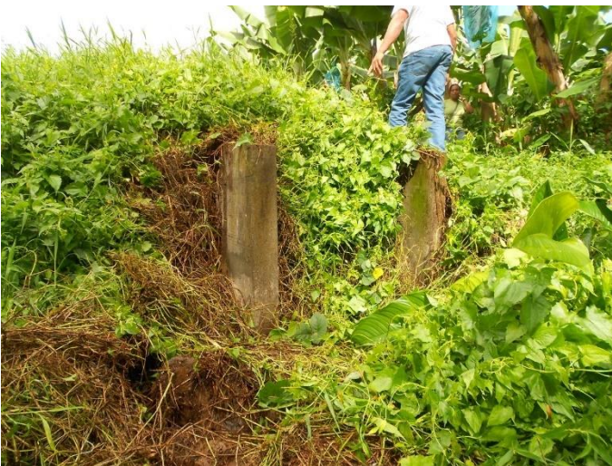
Figure 3.15 - Rejet de la STEU recouvert
